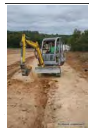
PHOTO 19: REALISATION DES TRANCHEES
