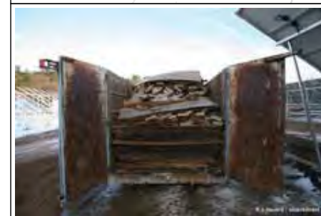
PHOTO 22: TRI SELECTIF SUR LE CHANTIER DE VINON
