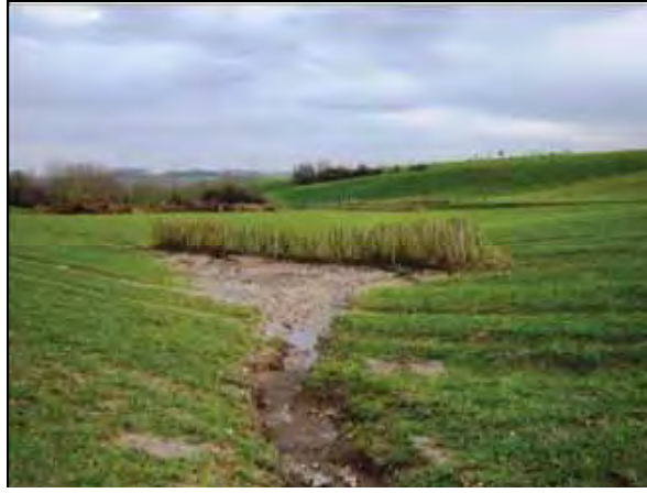
Fascine disposée dans l'axe d'un ruissellement concentré
